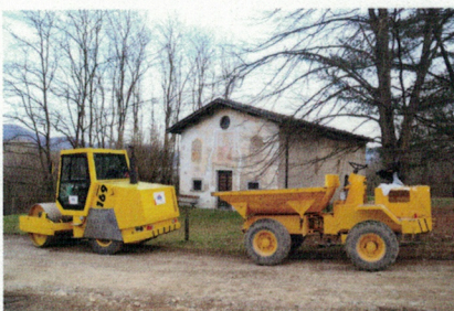
Lavori in corso (01.03.2015)
