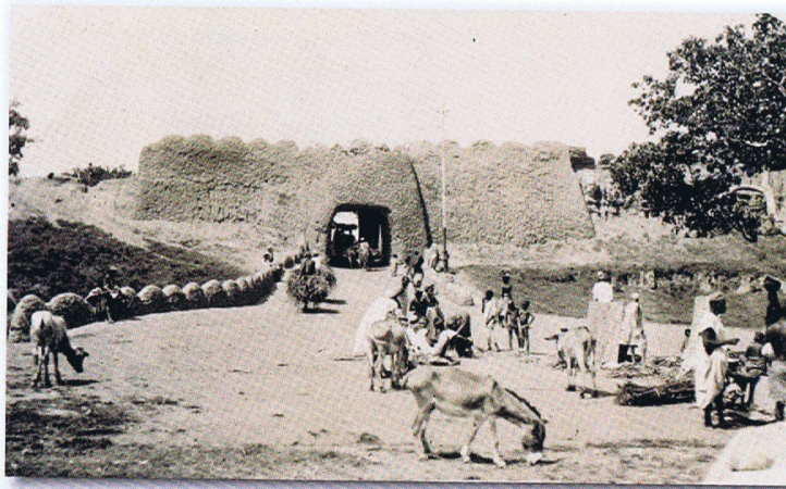
ENTRATA DI UN VILLAGGIO PRESSO KANO
